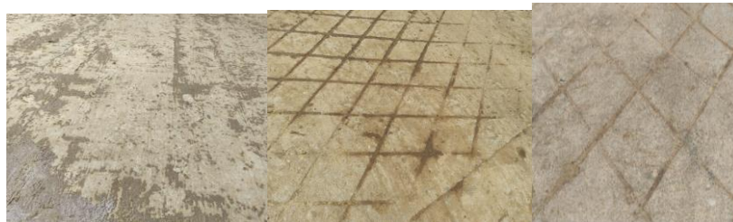
Figura 19. Condiciones de pisos en: establo (a); sala de espera (b); sala de ordeño (c)
