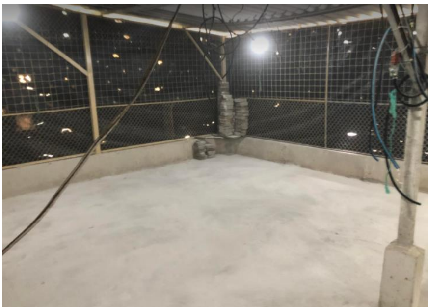
Anexo 2: Caleado interno de la nave; piso y paredes
