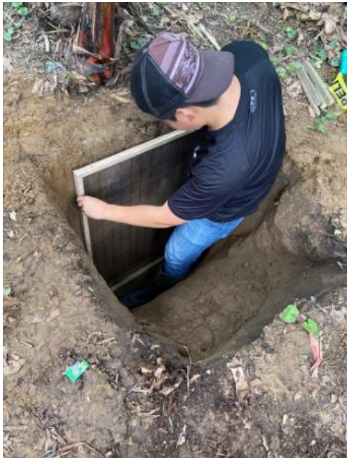
Figura 5: Colocación de marco con plástico en la calicata
