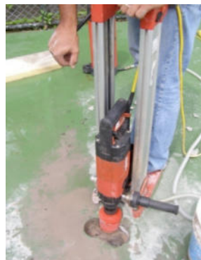
Ilustración 2: Extracción de una muestra (núcleo de concreto). Fuente: [11]
