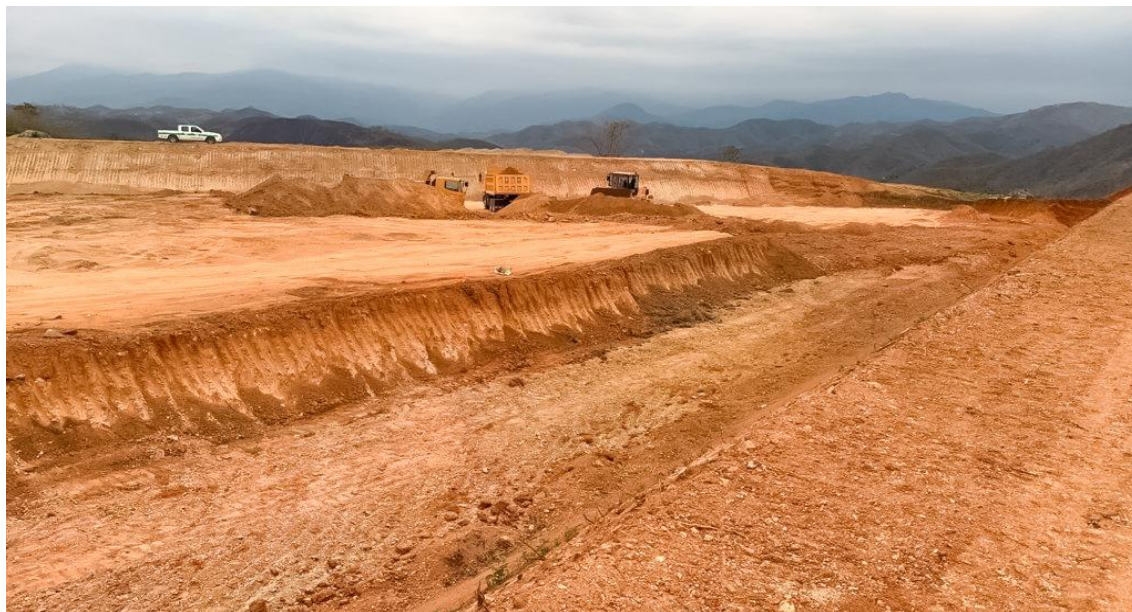
Ilustración 1 Sector "El Chiche" donde se construye la Empresa Pública Mancomunada para la Gestión Integral de Residuos Sólidos (EMGIRZAPP EP)
