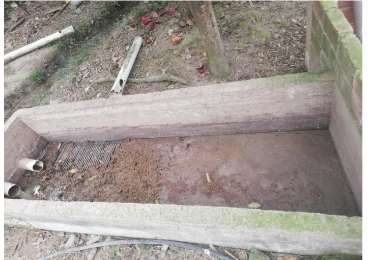
Figura 10. Separador de líquidos y sólidos de excretas.
