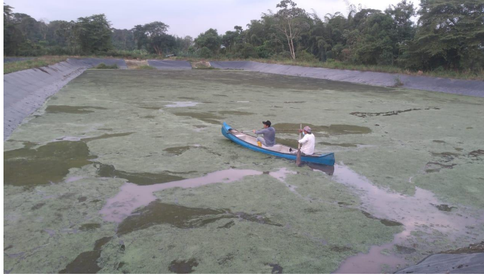
Ilustración 25. Laguna de maduración. Fuente: Elaboración propia
