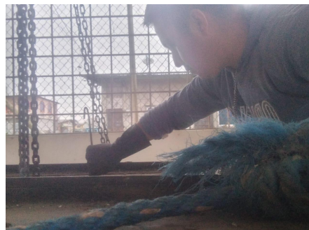
Ilustración 18. Ejecución de aforo en el afluente de la estación de bombeo. Fuente: Elaboración propia
