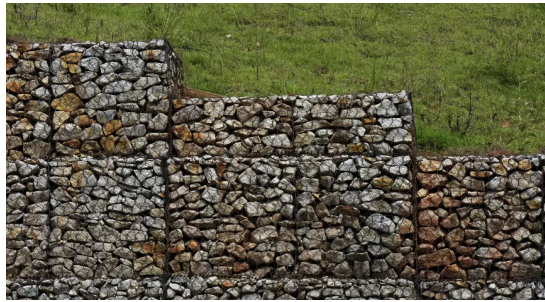
Figura 6 Muro de gaviones
