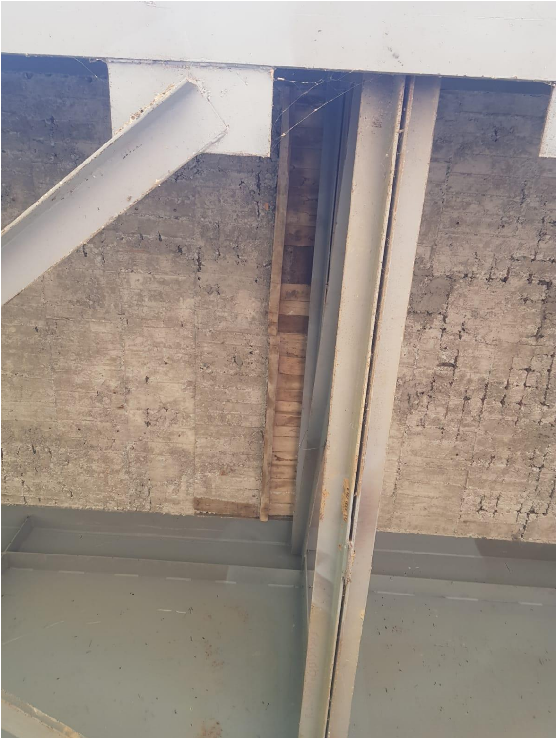
Anexo 9 Encofrado utilizado en la fundición del tablero.
