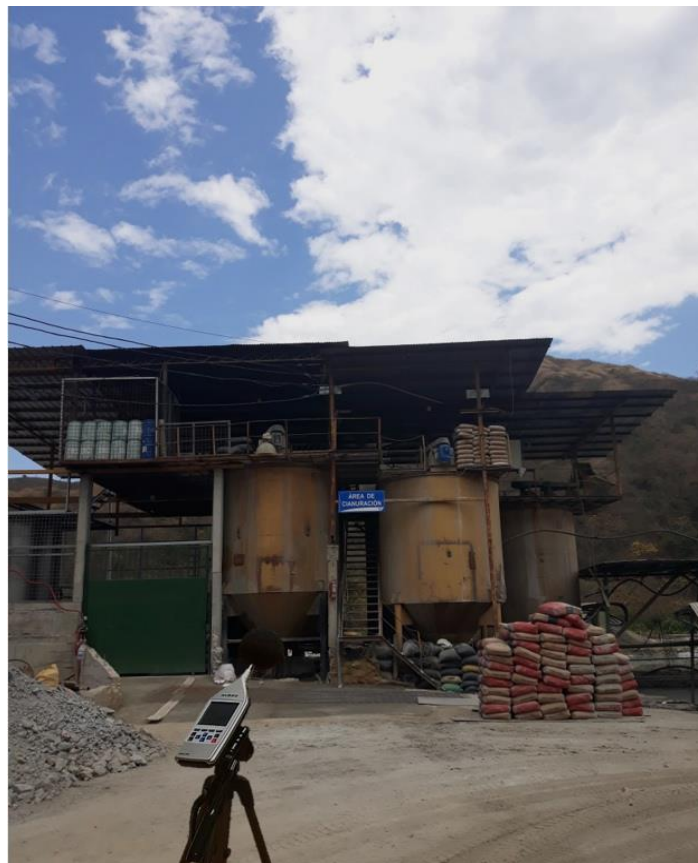
Área de cianuración
