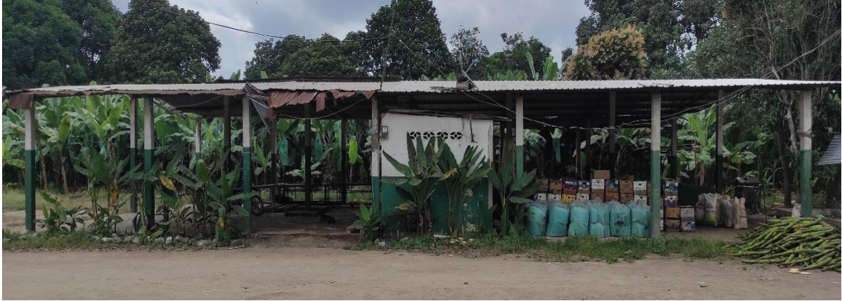
Figura 1 Fotografía de la vista general de la empacadora
