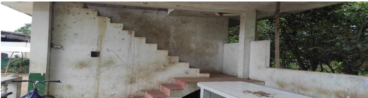
Figura 13 Fotografía de la escalera hacia la planta alta de la vivienda principal
