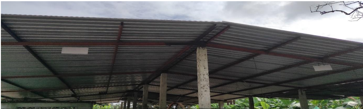
Figura 2 Fotografía de la cubierta de la planta empacadora
