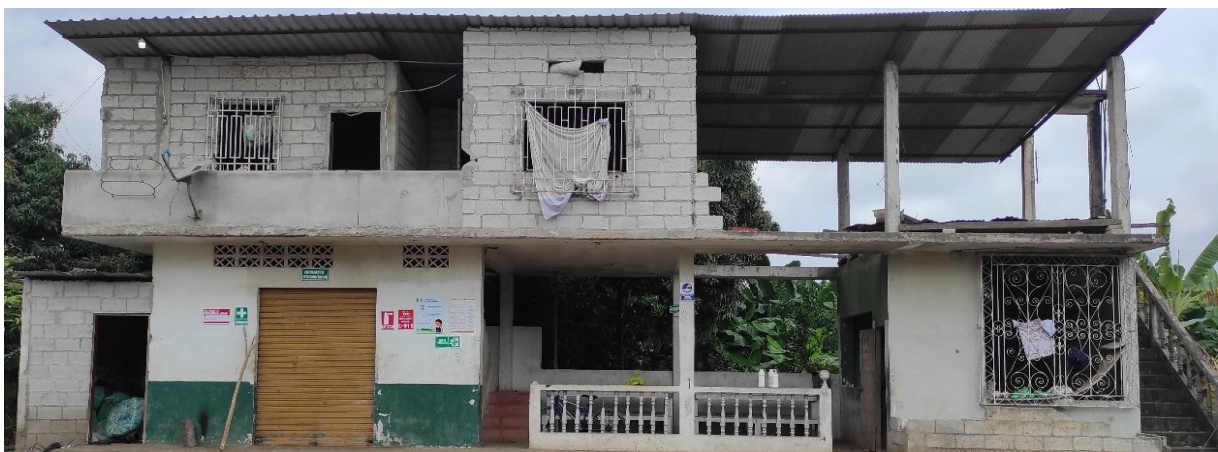
Figura 11 Fotografía de la vista frontal de la vivienda principal
