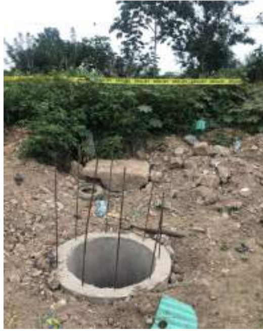
Fotografía 6. Red de alcantarillado
