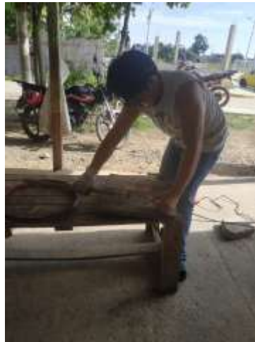
Imagen 25 proceso de doblar las varillas
