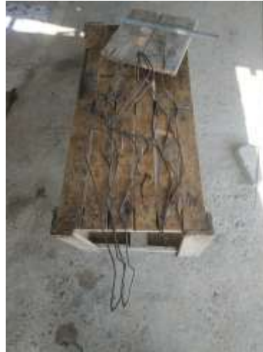
Imagen 26 obra armada y soldada
