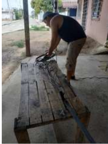
Imagen 30 desbaste de los puntos de suelda y limpieza
