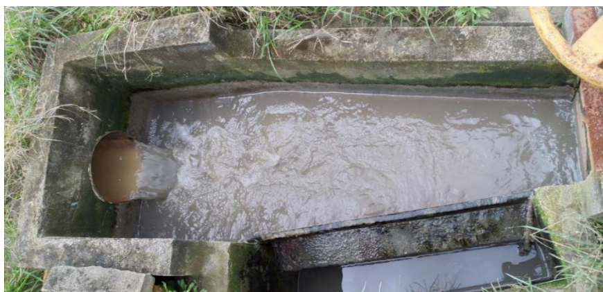
Figura 2. Cajón de ingreso a la PTAR
