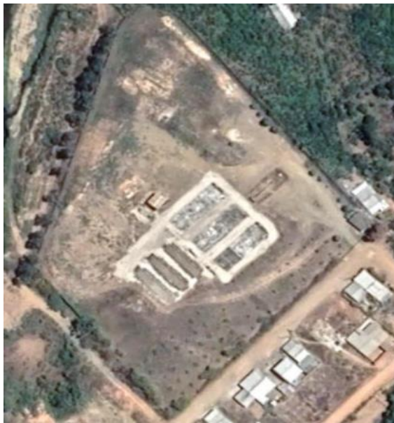
Figura 1. Ubicación de la planta de tratamiento
