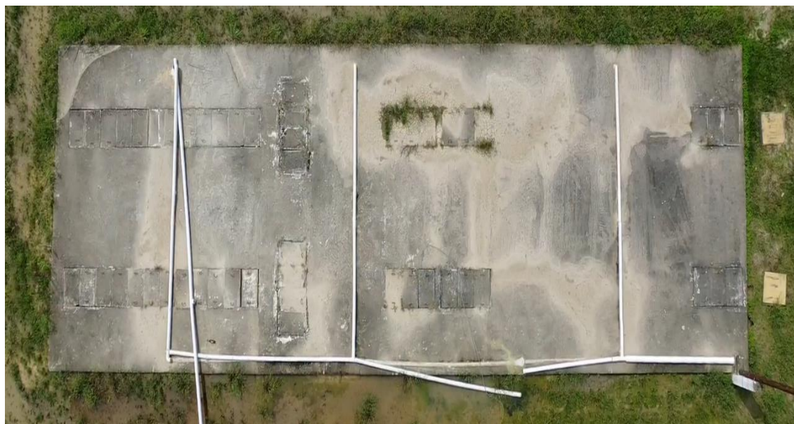
Figura 7. Tanque Séptico y Filtro Anaerobio
