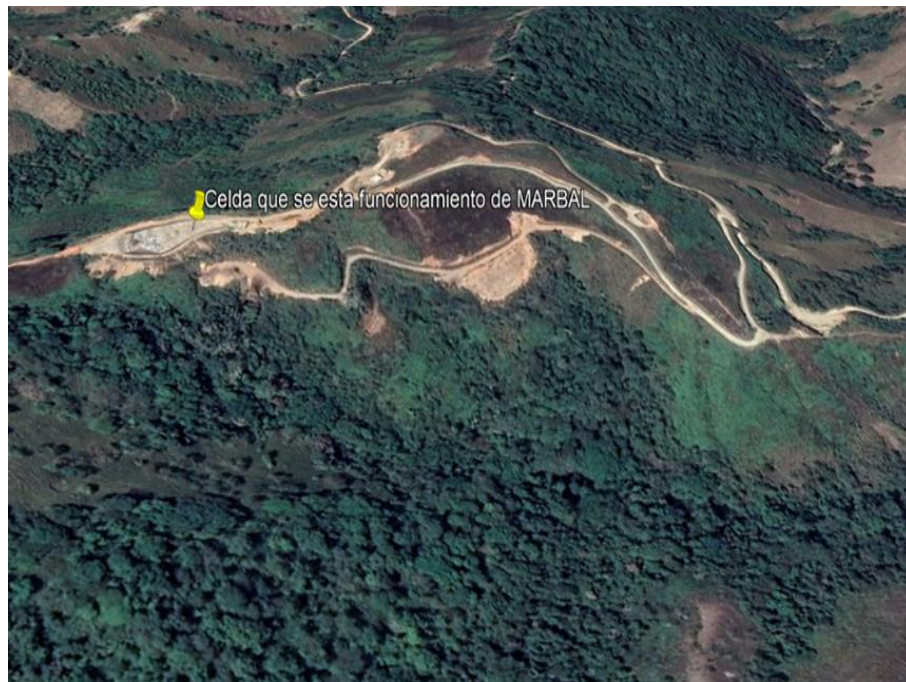
Ilustración 29. Ubicación de celda en funcionamiento
