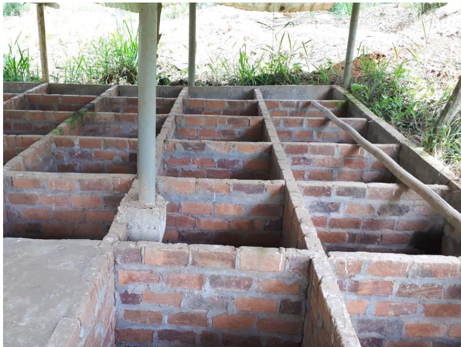
Ilustración 27. Celda para Residuos Sanitarios
