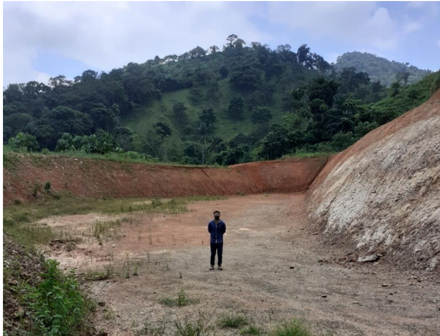
Ilustración 28. Visita a nueva celda
