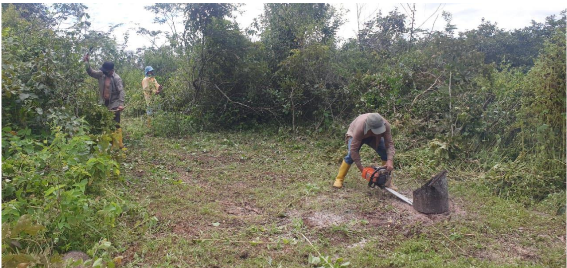
Ilustración 13 Trabajos de limpieza para la construcción de la primera celda
