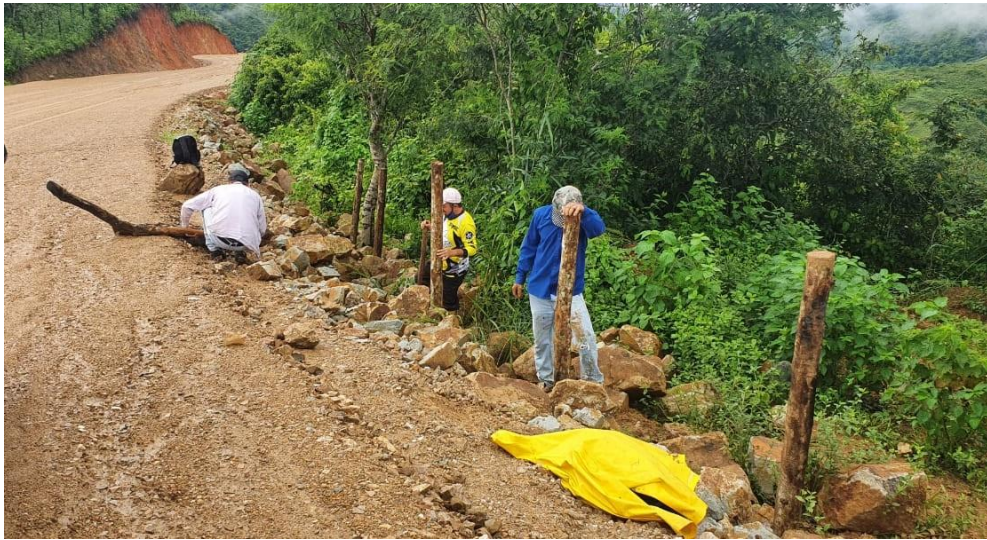
Ilustración 11. Cercado de la vía de acceso al relleno sanitario de la Mancomunidad (Trabajos actuales)
