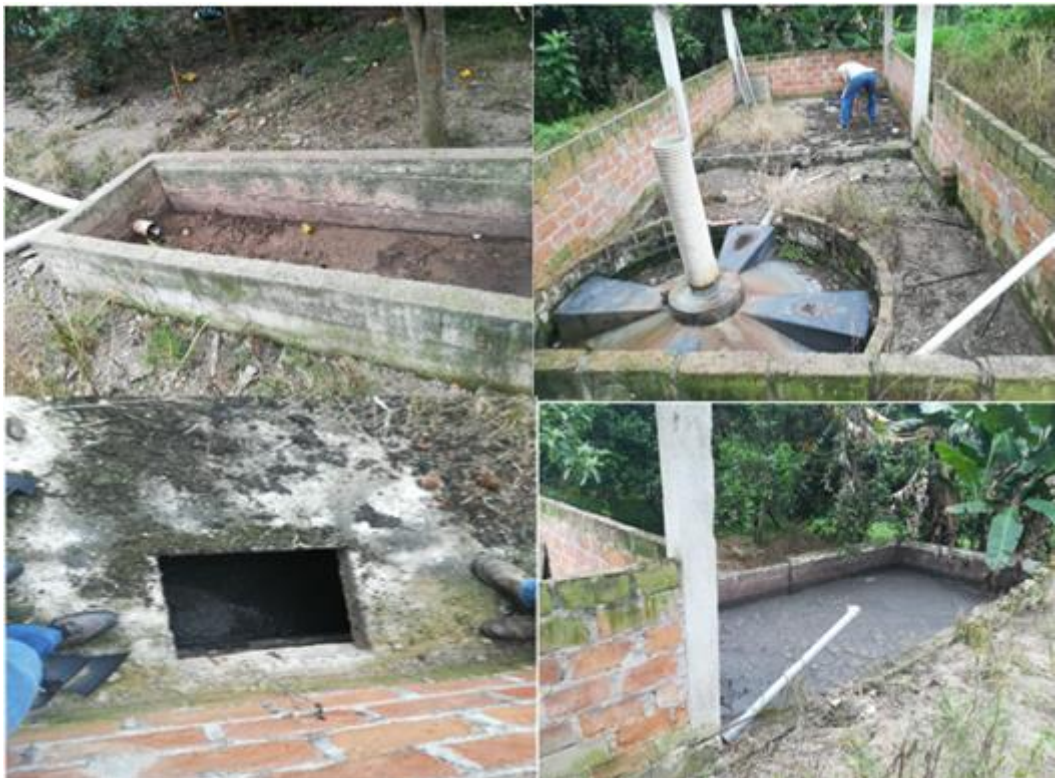
Figura 16. piscina de tratamiento de los purines.
