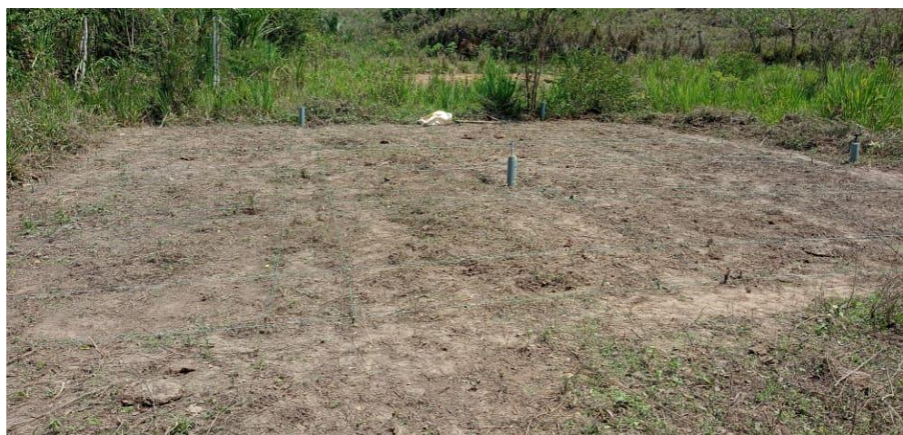
Figura 13. Limpieza del terreno.
