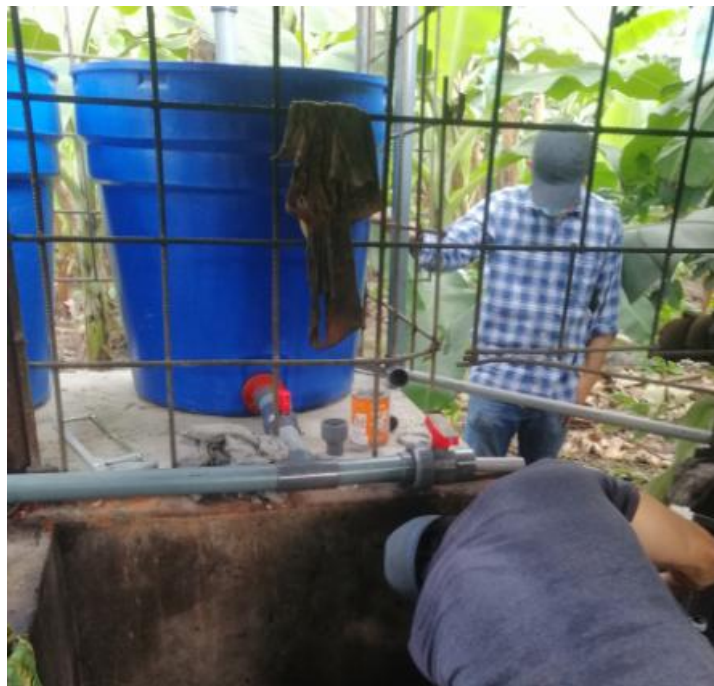
Anexo 6: Instalación de tanques para fertirriego
