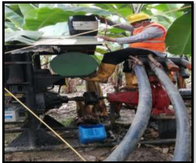
Unidad de Control y Riesgo mitigando el incendio.
