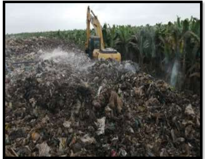
El incendio ocurrido en el mes de septiembre, provocó la intoxicación de los moradores.
