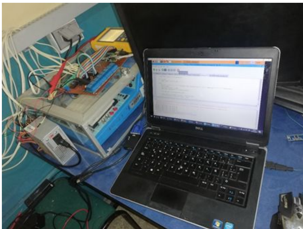
Anexo 6: Conexión en tablero de Control
