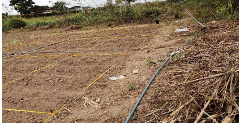
Figura 20. Instalación de las tuberías para el sistema de riego por aspersión.
