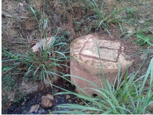
Figura 4. Pozo de revisión y descarga libre. Fuente: La Autora
