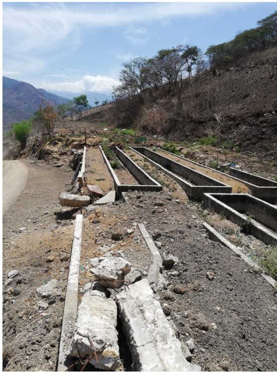
Ilustración 8 : Camas para realizar compost del Relleno Sanitario.
