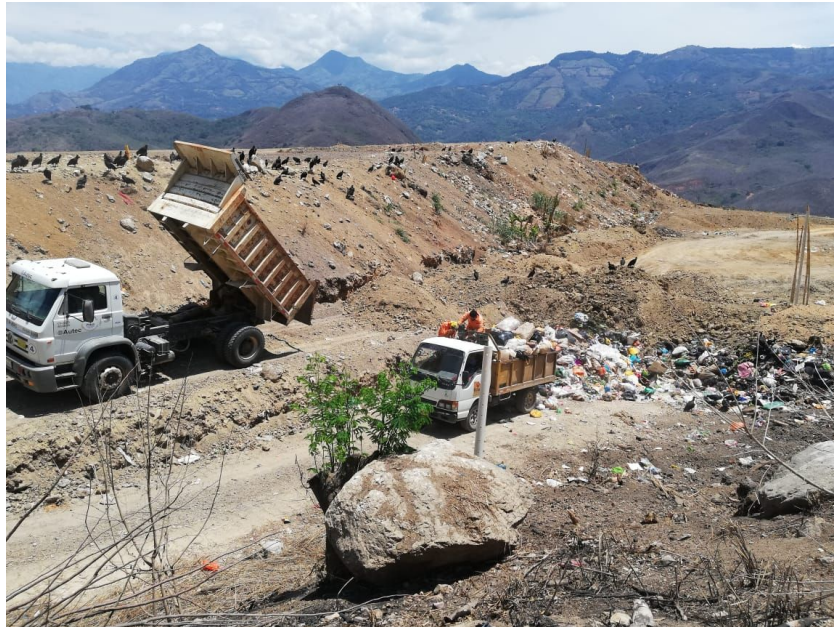
Ilustración 9: Transporte y vaciado de los desechos sólidos.
