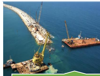
Figura 8. Pontonas con grúa sobre cubierta
