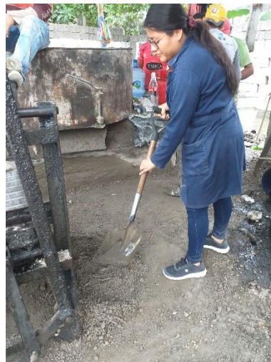
Fotografía 14: colocación de la mezcla a los moldes,
