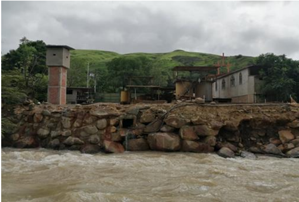
Anexo 10 Descarga de aguas residuales de planta de beneficio al río Amarillo.
