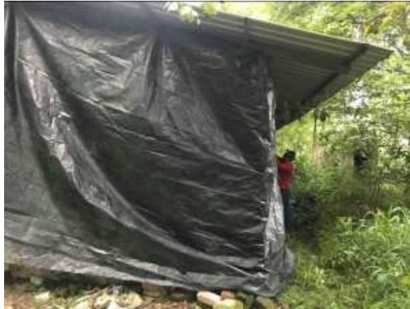
Anexo 4 Colocación de plásticos al galpón
