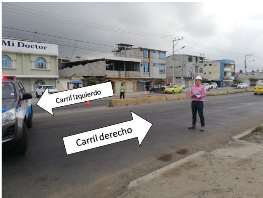
Fig. 7 Tramo de la vía que se evalúa
