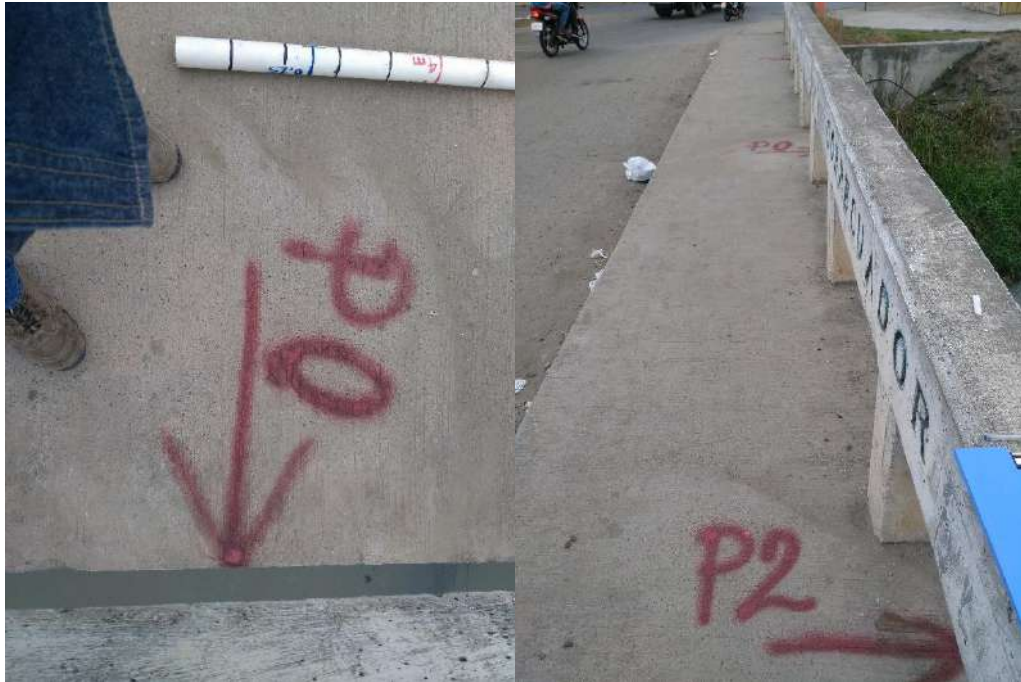
TF 5. Marcas en los puentes sobre el canal.
