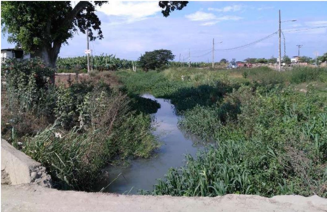
TF 12. Canal El Macho desde el puente en la Lotización Leonor Aguilar.
