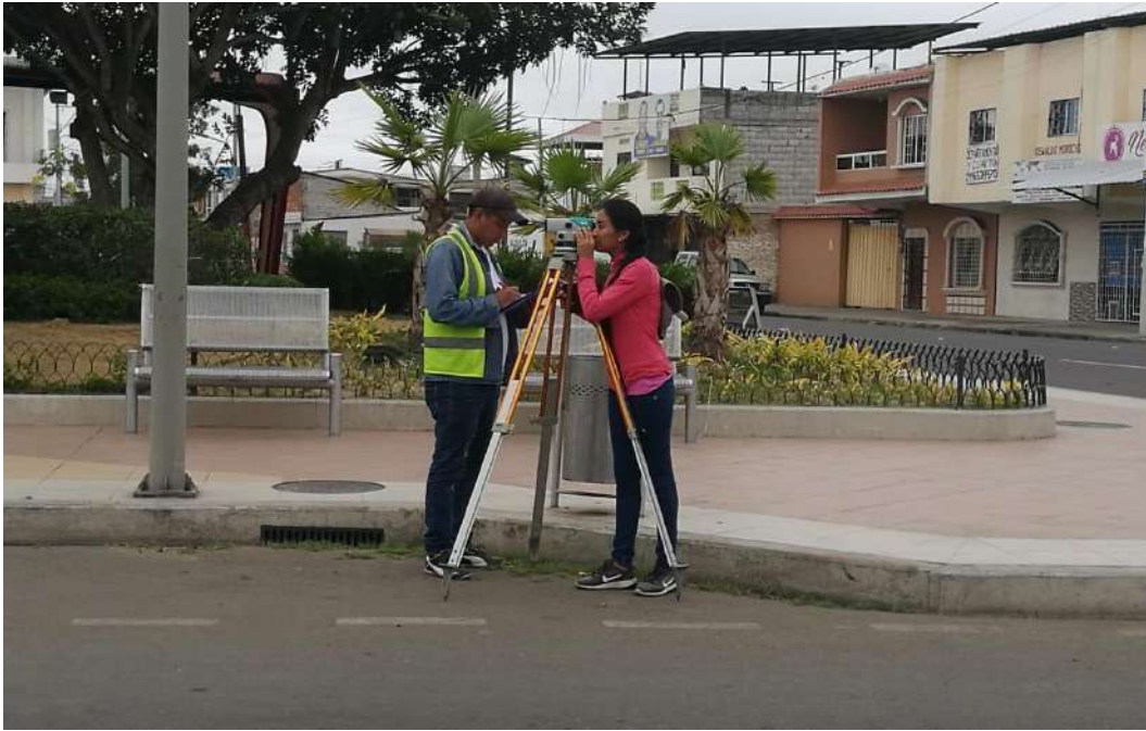
TF 1. Nivelación en las principales calles de la ciudad de Machala
