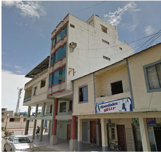
Figura 2. Estructuras que no presentan la debida separación.
