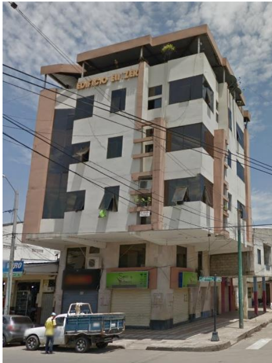
Figura 1. Edificio con irregularidad en elevación.
