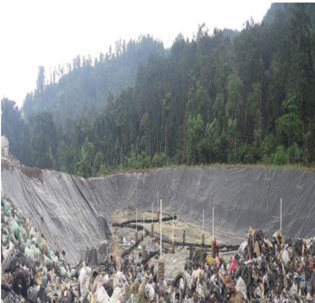
Fotografía 9 Cierre técnico y apertura de la celda emergente.
