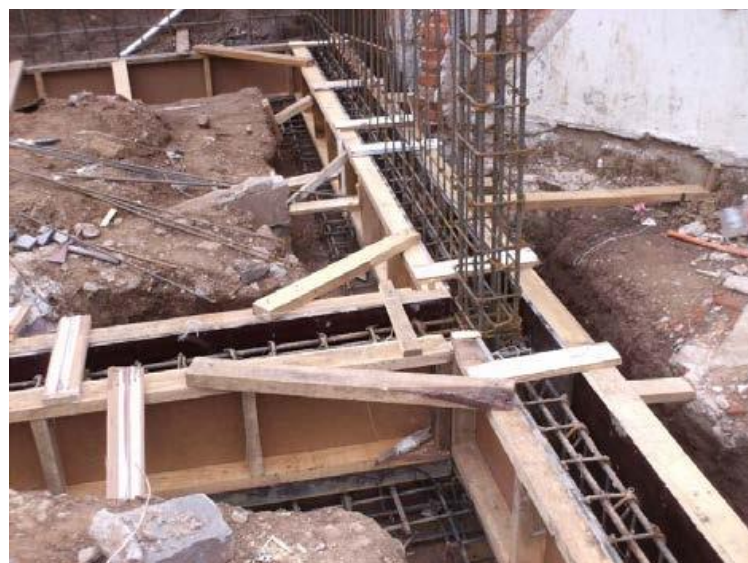
Ilustración 41: Encofrado de zapata corrida Fuente: Procedimientos de construcción de cimentaciones y estructuras de contención, Piqueras Víctor Yepes 2016.
