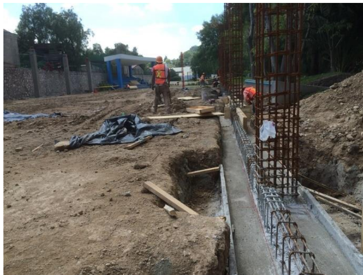
Ilustración 40: Zapata corrida en proceso de encofrado Fuente: https://fotos.habitissimo.com.mx/foto/zapata-corrída_307042
