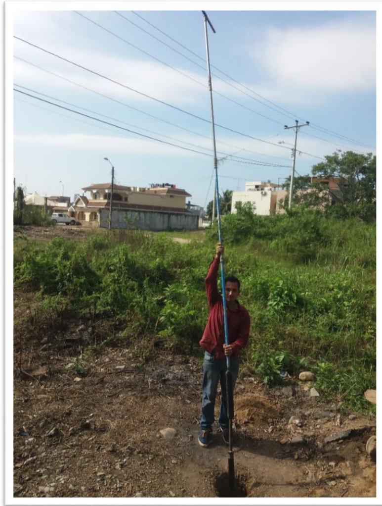
Extrayendo el martillo con la muestra en el tubo shelby, sondeo 4
