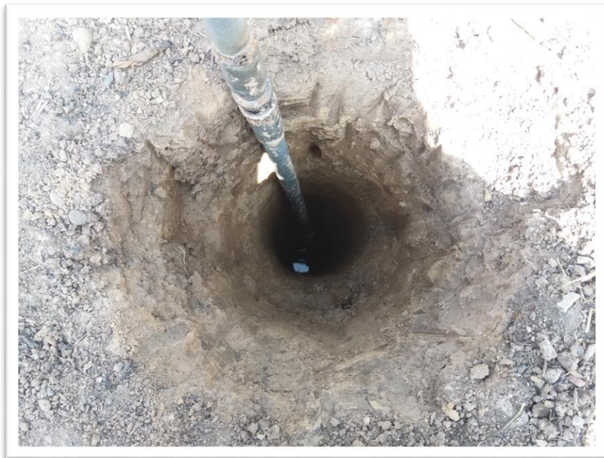
Perforación en proceso sondeo 4
