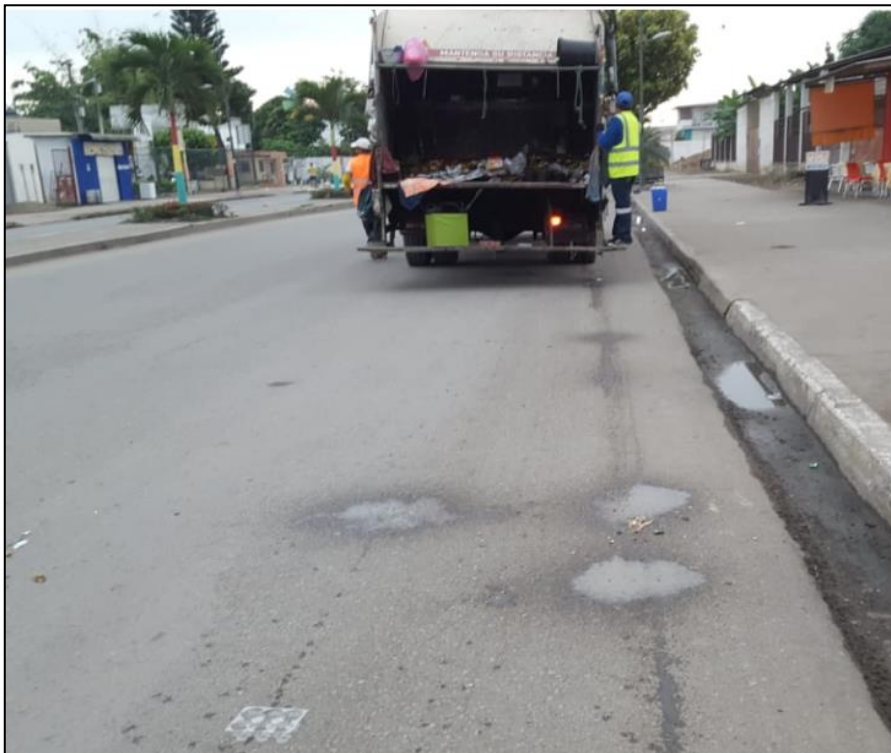
Lixiviado en la vía Panamericana Sur
