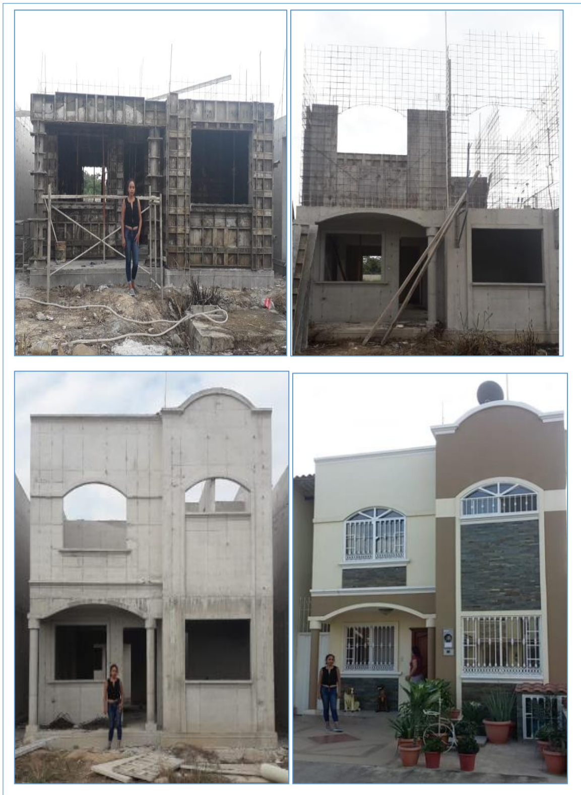
Ilustración 17. Vivienda tipo de dos pisos con el sistemas de ductilidad limitada - caso muros estructurales portantes. Fuente: Autor de este documento
