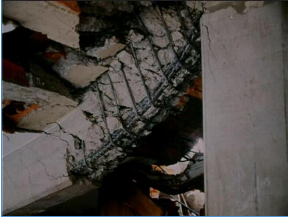
Ilustración 7. Flexión en vigas. Fuente: Sambrano, 2015
