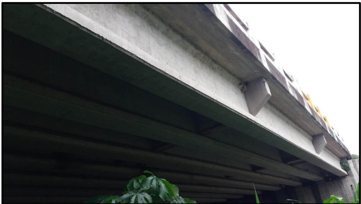
Diafragmas y vigas de la superestructura del puente.
