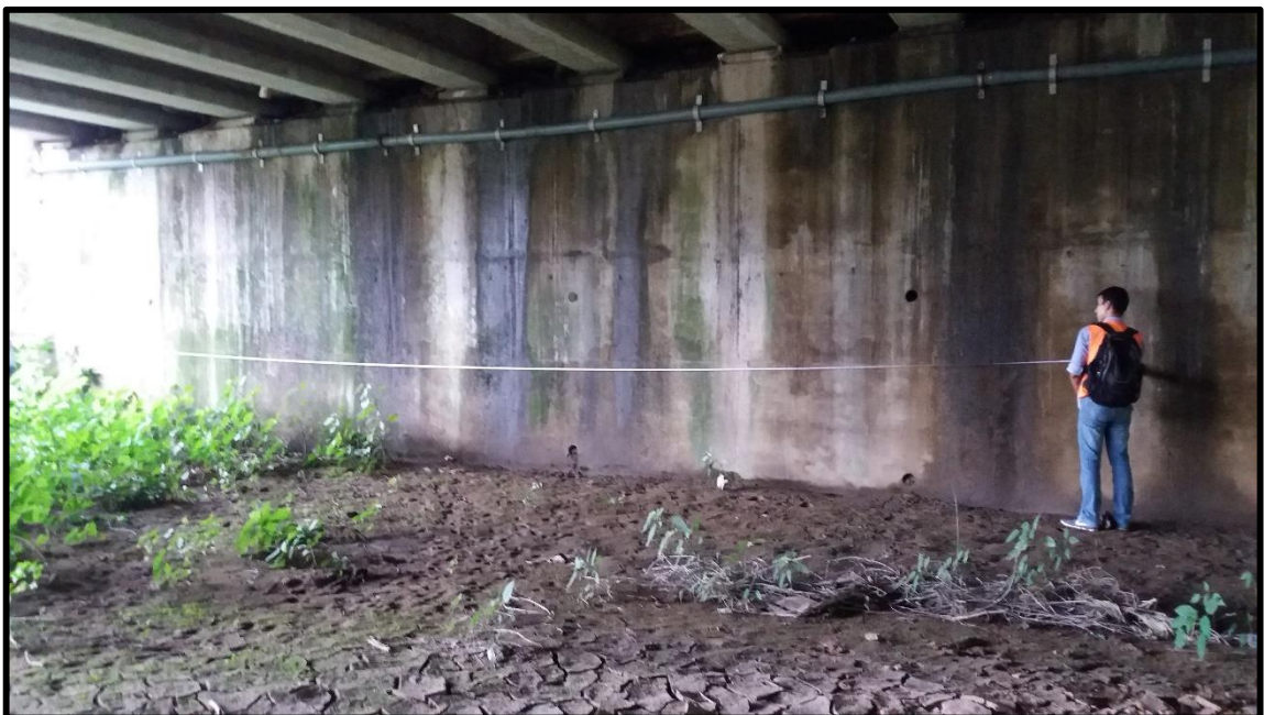
Medición de la sección transversal del puente, por debajo de la superestructura.
