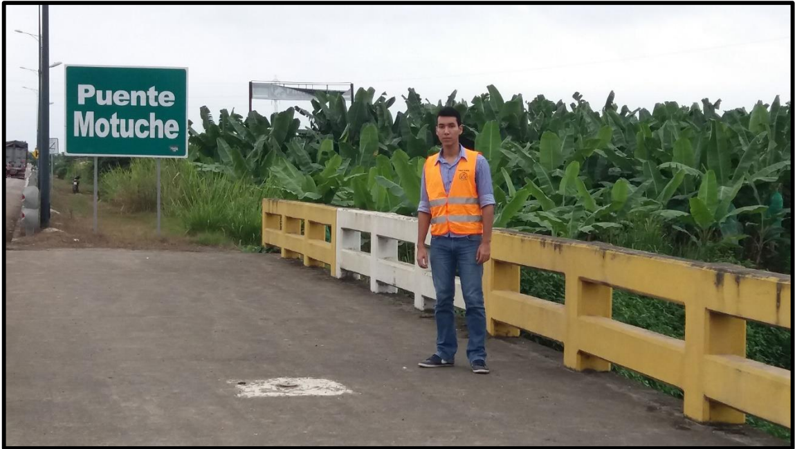
Visita al puente ubicado sobre el río Motuche.
