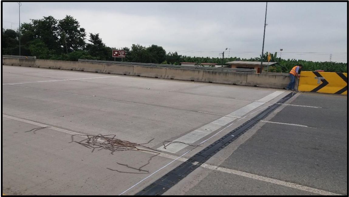
Medición de la sección transversal del puente, por encima de la superestructura.
