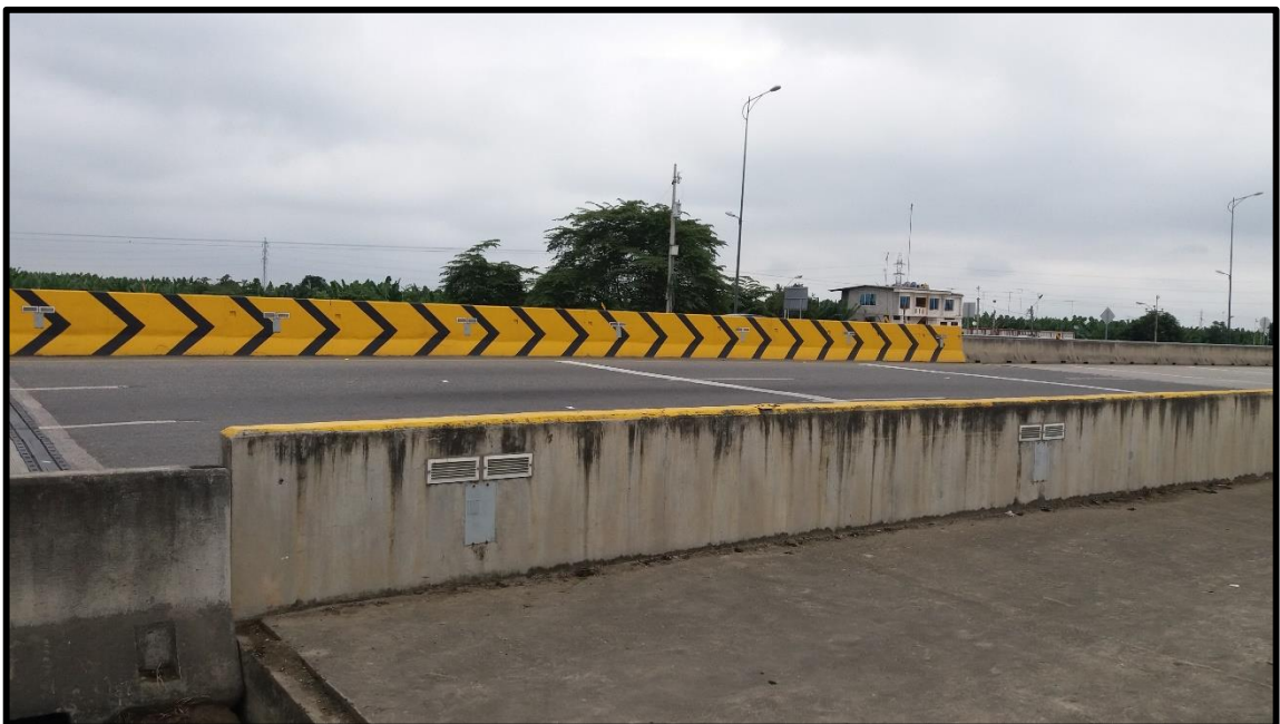
Barandas Tipo New Jersey que se disponen en el puente.
