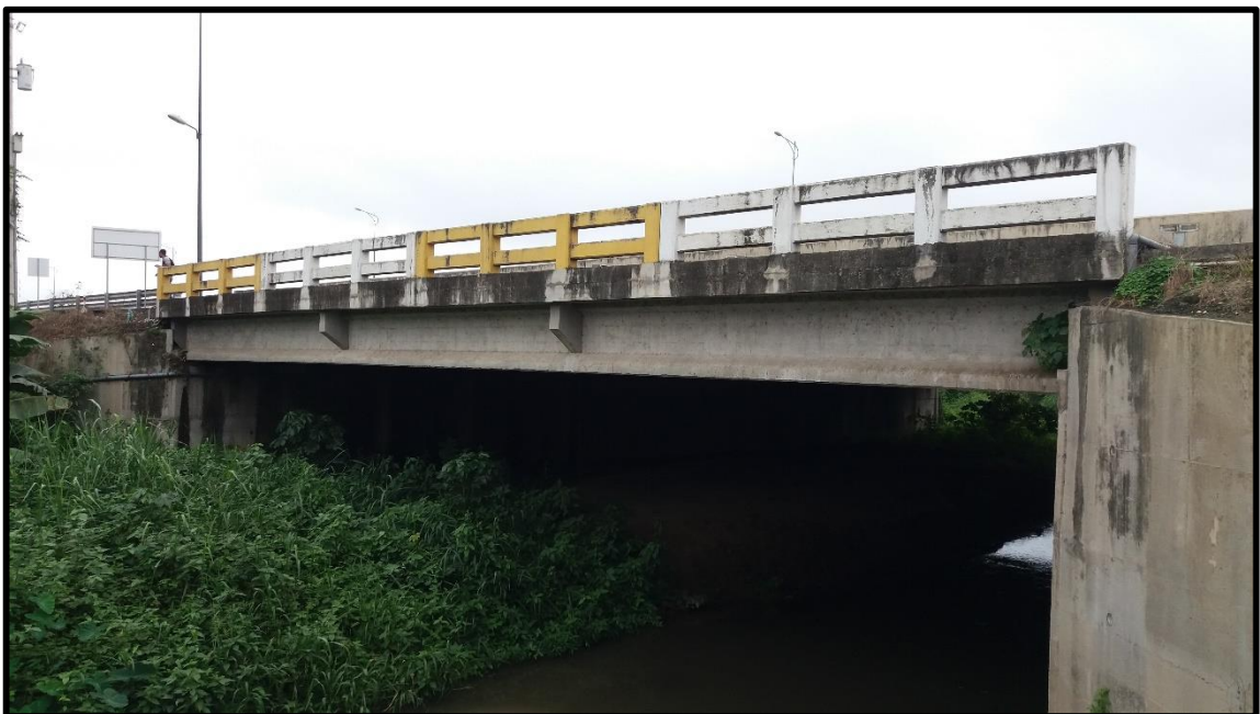
Vista longitudinal del puente "Motuche".
