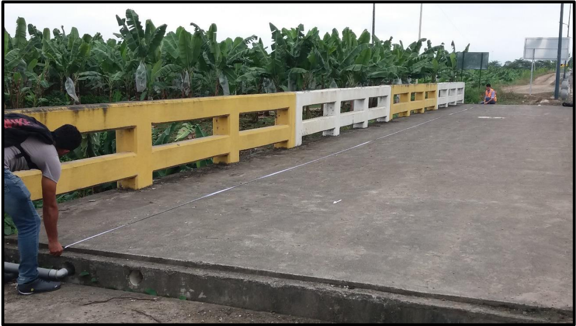
Medición de la sección longitudinal del puente.
