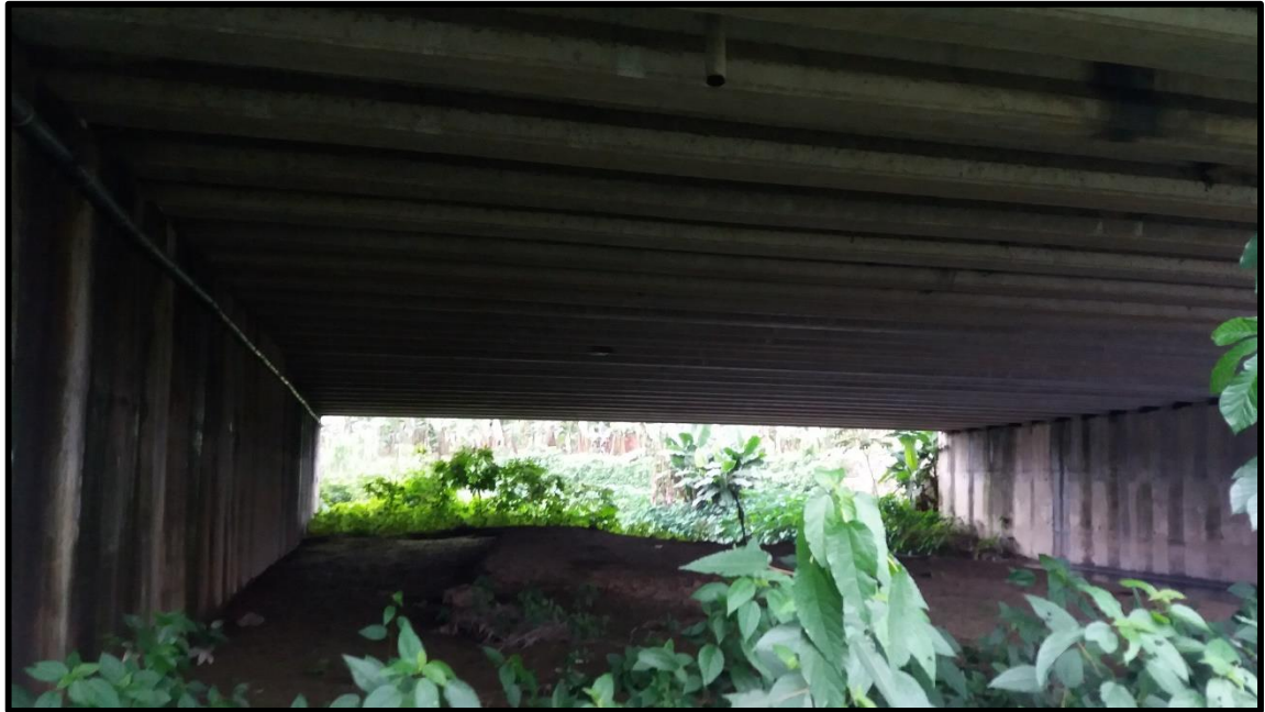
Vigas y estribos del puente “Motuche”.
