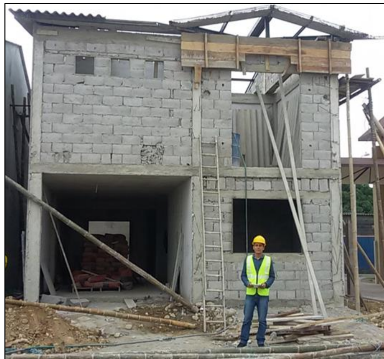
Gráfico 2. Visita a construcción de vivienda con sistema de pórticos resistentes a momentos.
