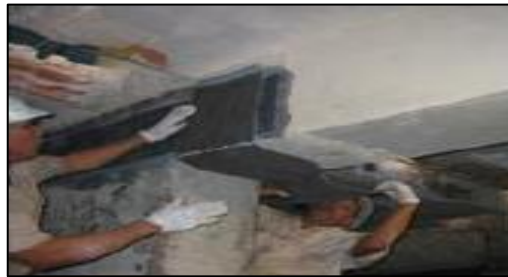
Gráfico 10. Colocación FRP en estructuras
