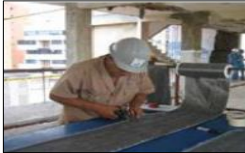
Gráfico 9. Preparación del Reforzamiento con FRP
