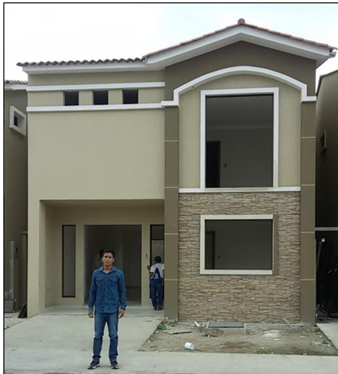
Gráfico 4. Vivienda con pórticos resistentes a momentos en fase de acabados.
