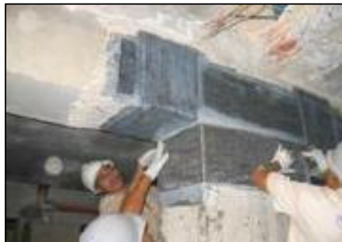
Gráfico 11. Acabados sobre el FRP para reforzamiento estructural
