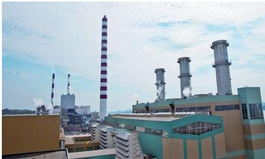
Ilustración 21. Planta generadora de electricidad con biomasa y metano en SENOKO
