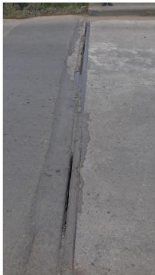
Juntas de dilatación entre estribo y puente
