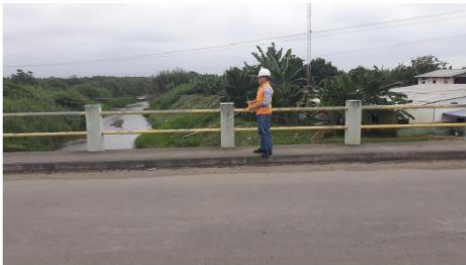
Medición de la longitud del Puente El Checo – (Luz = 35.60)
