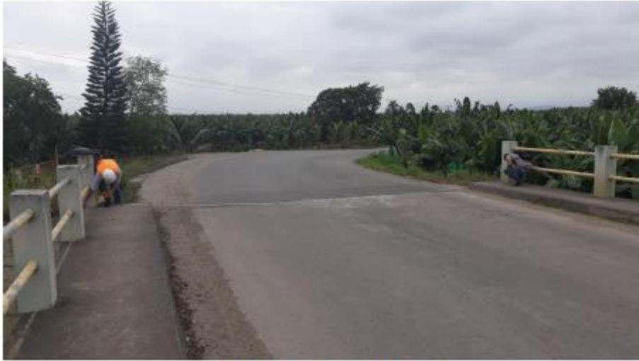
Medición del ancho del Puente El Checo
