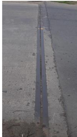
Juntas de dilatación entre estribo y puente
