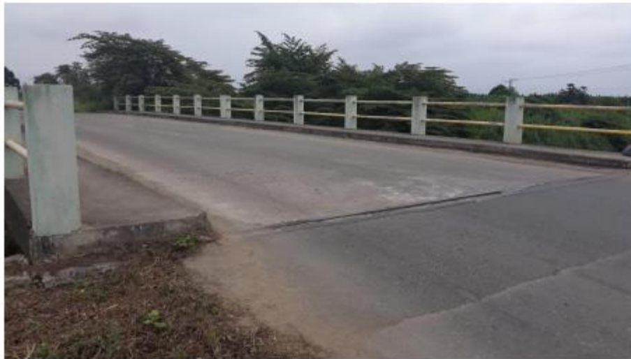
Juntas de dilatación entre estribo y puente
