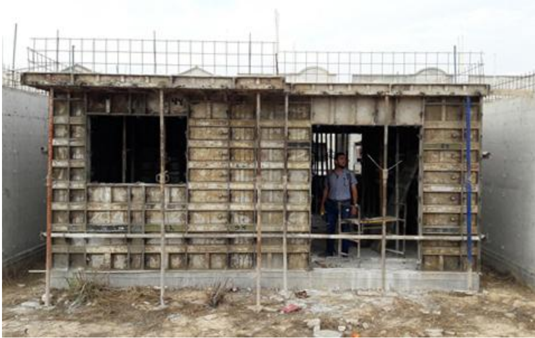
Figura 3 Producción en serie mediante Formaletas Metálicas Fuente: Propia
