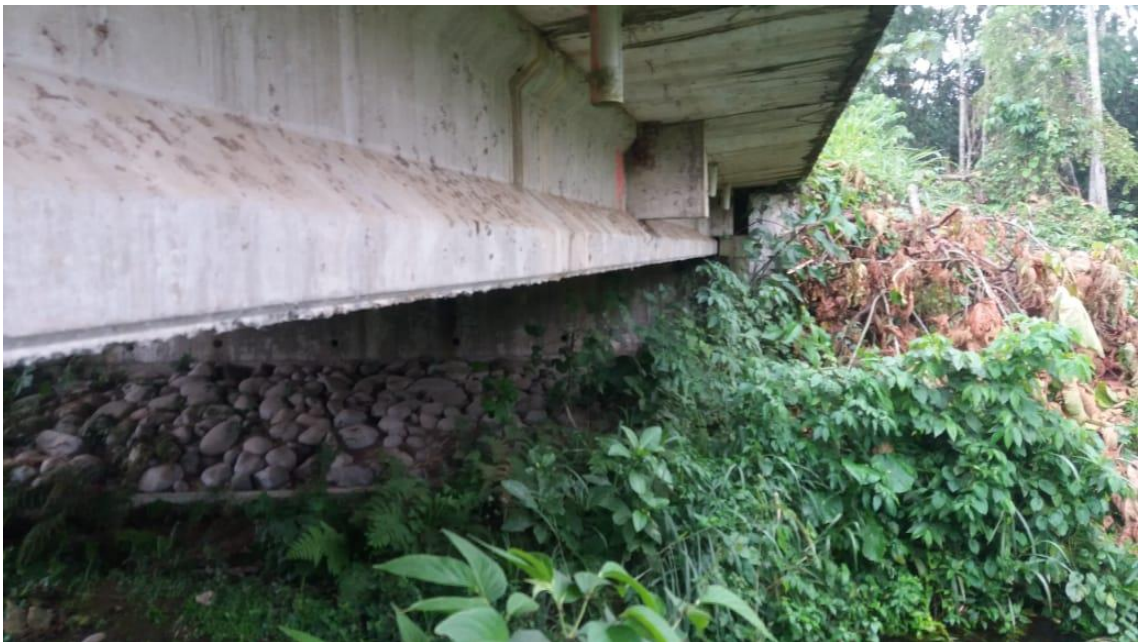
Vigas del puente de 15 m de longitud sobre la quebrada Palenque
