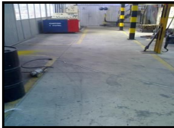
Figura 3. Pintura del piso
