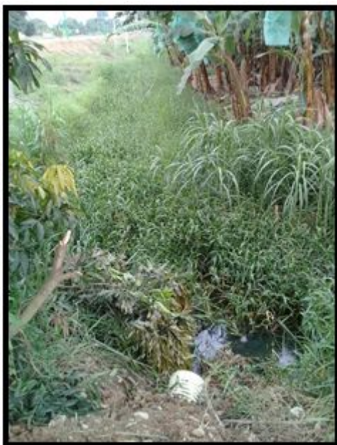
Figura 3.- Canal de drenaje para bananeras del sector (foto jroldan).
