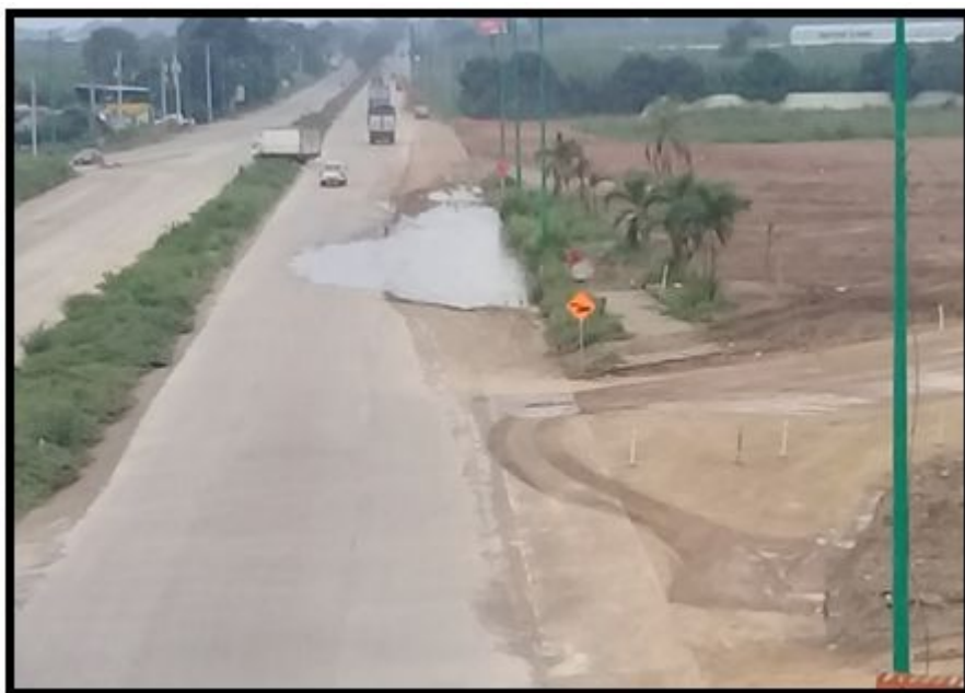
Figura 2.- AALL estancadas, obstaculizando la vía Machala-Pasaje (foto jroldan).
