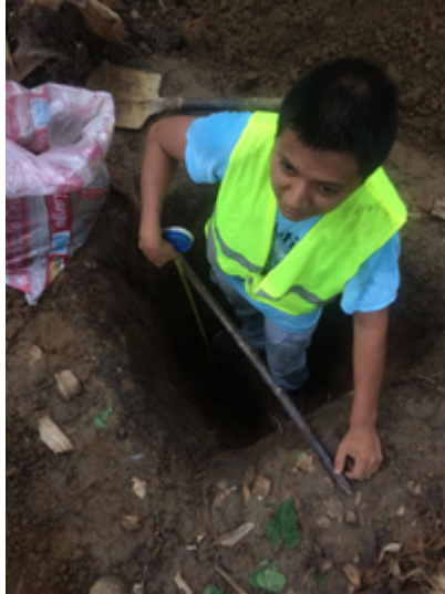
Figura 1. Excavación para obtención de calicatas
