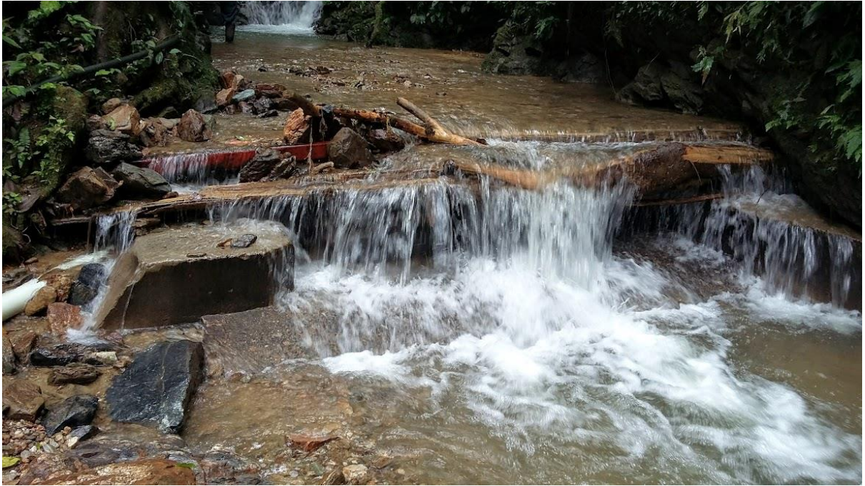
Captación del afluente de agua superficial denominada “la Cascada”.
